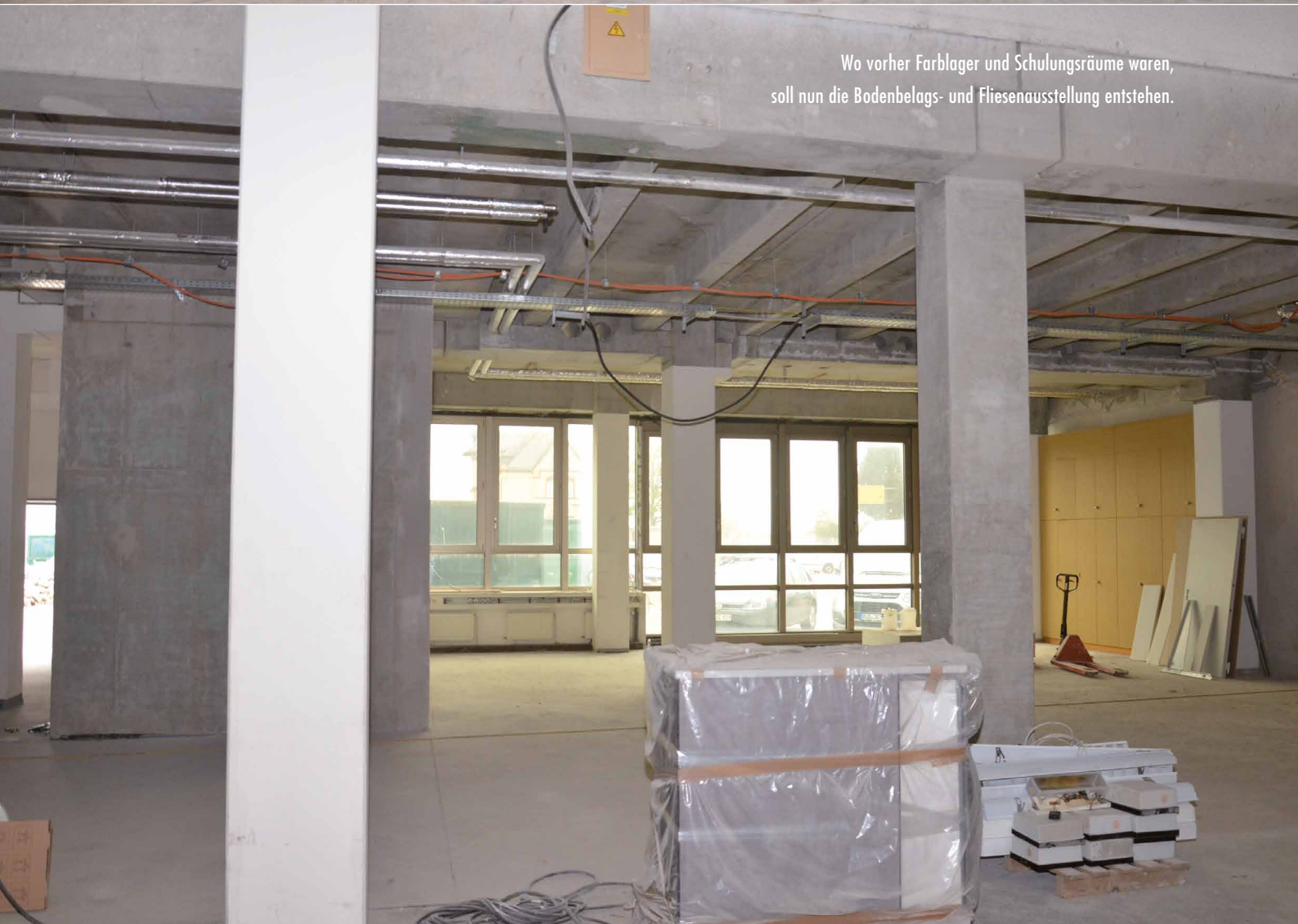
Arbeiten an der Decke: Blick in die Halle im April 2016.
