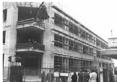
Richtfest für das neue Bürogebäude am 24. November 1988.
