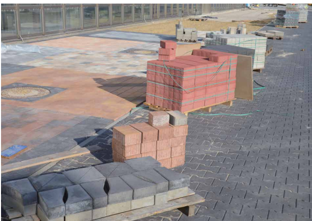
Der Vorplatz wird mit unterschiedlichen Steinen neu gepflastert.
