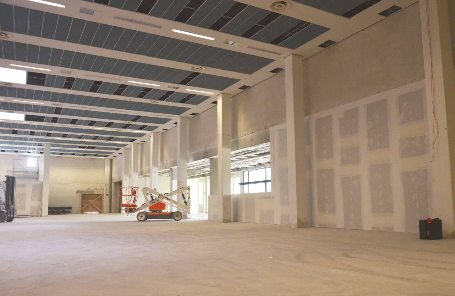
Mithilfe von Trockenbau-Wänden wird eine neue Raumaufteilung vorgenommen.
